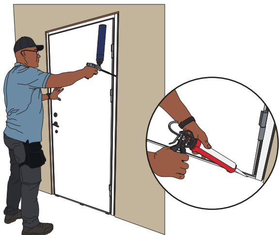
STEP 16. Afhængig af produktets specifikationer stoppes og fuges mellem væg og dørkarm.: polyuretanskum Penosil Premium Fire Rated i brandklass B1, stenull Paroc Extra.
