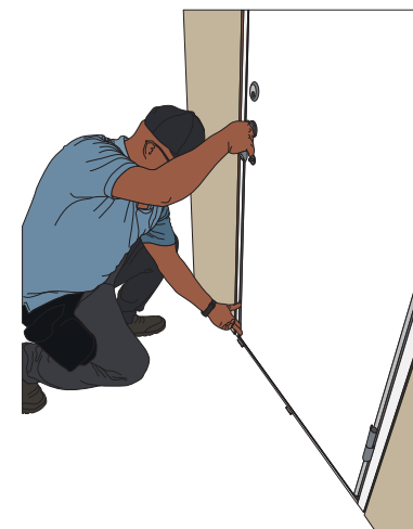
STEP 15. Klods op under midten og under låsesiden, når begge sider af dørkarmen er monteret i væggen.
